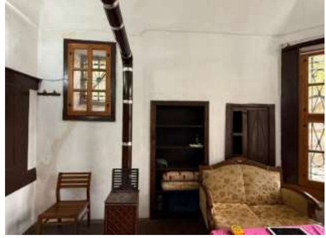
İç mekân kuzey duvarı
