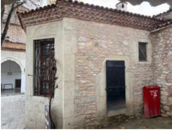
Kuzey (Sağ yan) cephe
