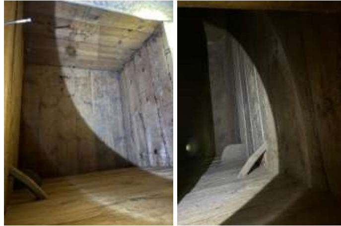
Şekil 12. Ambar içerisindeki gemici merdiveni
