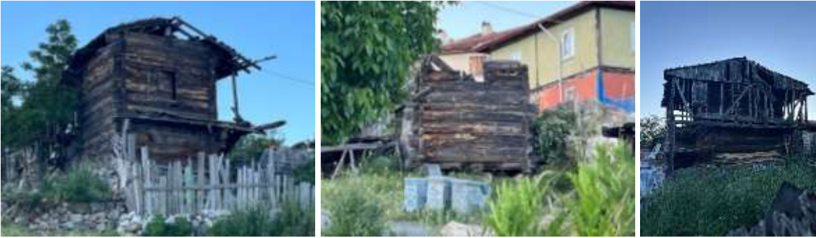
Şekil 3. Topçalı köyünde bulunan ambar yapıları
