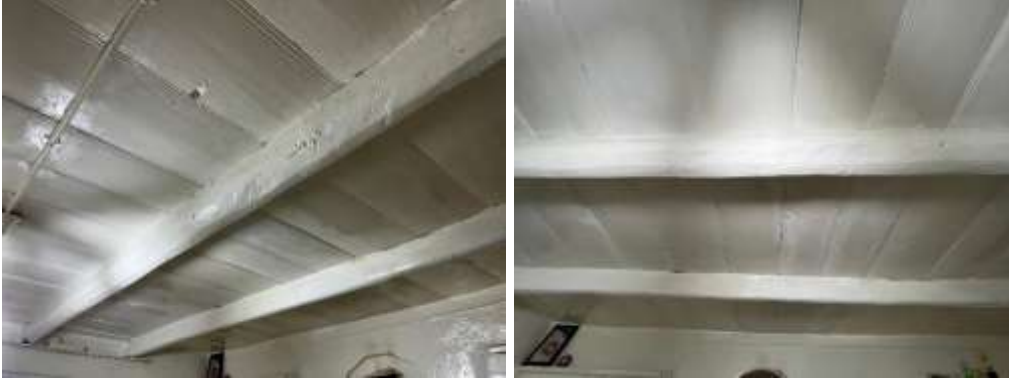
Şekil 21. Ahşap tavan ve kiriş sistemi
