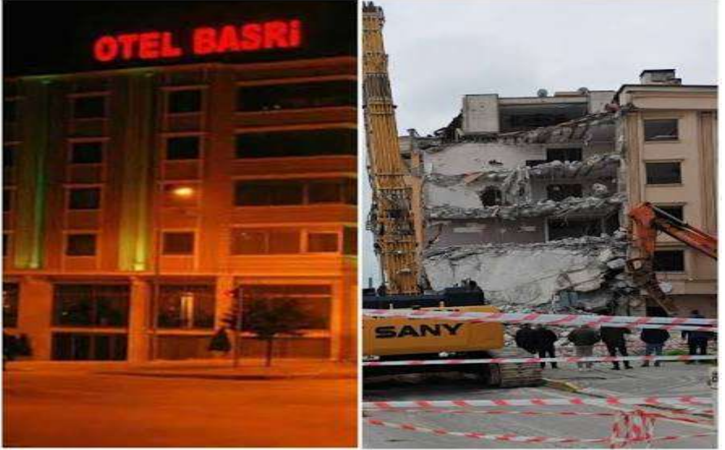
Görsel 3 Yıkım Öncesi ve Sonrası Karşılaştırılması
